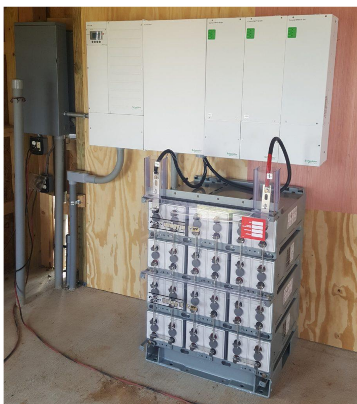
Figura 3.3: Exemplo de sistema de baterias estacionárias utilizadas em Sistemas Fotovoltaicos. Fonte: (MTVSOLAR, 2017).
